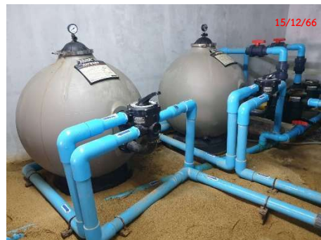
ภาพที่ 2.2-13 ระบบกรองของสรว่ายน้ำ
