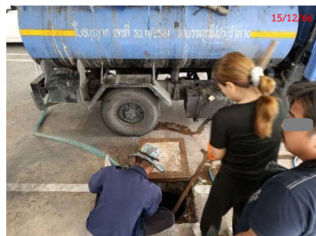
ภาพที่ 2.2-8 การทำความสะอาดบ่อดักไขมันและการสูบล้างถัง
