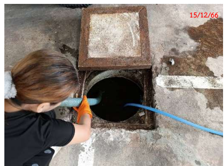
ภาพที่ 2.2-8 การทำความสะอาดบ่อดักไขมันและการสูบล้างถัง
